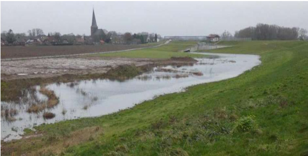
Abbildung 79: Blick auf das neu errichtete Schöpfwerk des Deichverbandes Xanten-Kleve im Unterlauf des Kellener Altrheins. (Foto: Arntz 17.12.2023)
