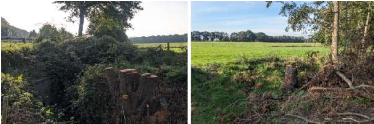
Abbildung 63: Die vom Eigentümer beauftragten Fällarbeiten betrafen sowohl beschädigte Bäume in Autobahnnähe als auch weitere, für die Verkehrssicherheit irrelevante Stämme. Im Zuge der Fällarbeiten wurde der Zaun zur angrenzenden Grünlandfläche beschädigt. Die Schadensbehebung wurde zwischen den betroffenen Parteien geklärt (Busch, 06.10.2023).
