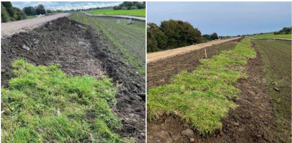
Abbildung 74: Rückübertragene Soden auf dem neuen Deich
