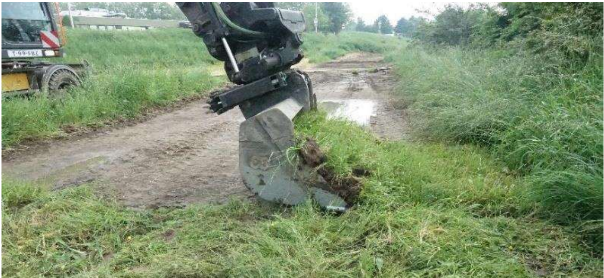
Abbildung 73: Ablage der Soden auf der Zwischenlagerungsfläche
