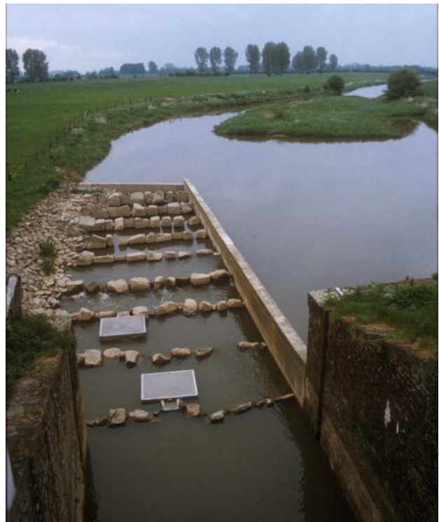
Abb. 9: Blick vom Sommerdeich in Richtung Bienener Altrhein. Im Vordergrund der obere Bereich der Fischtreppe mit den beiden eingesetzten Reusenkästen (Foto: M. Brühne).
