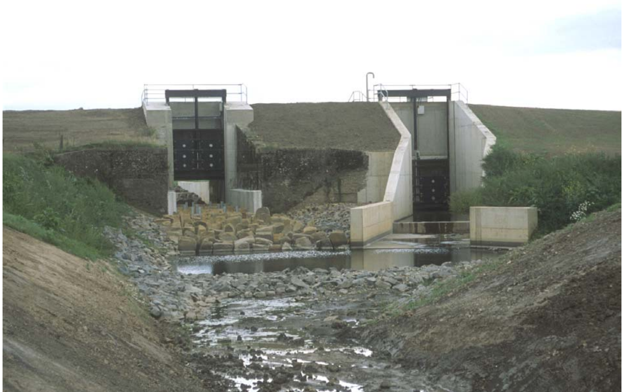
Abb. 7: Die Dornicker Schleuse nach dem Umbau. Links das alte Schleusenbauwerk mit dem neuen Hubtor und dem eingebauten Rauherinne-Beckenpass, rechts der neue Umfluter, ebenfalls mit einem Hubtor ausgestattet (Foto: M. Schwöppe).
