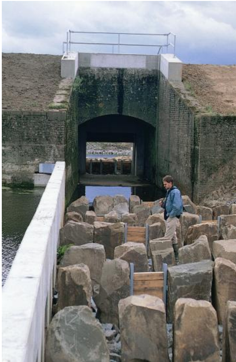
Fischaufstieg an der Dornicker Schleuse ermöglicht Rheinfischen im Altrhein zu laichen
